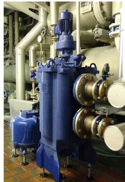
Fig. 3: BOLLFILTER automático tipo 6.64 DN125
