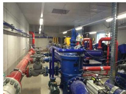
Bild 3: Filteranlage in der Pumpstation
