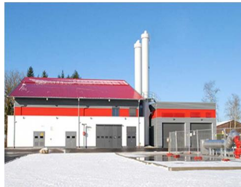
Central térmica de Ismaning
