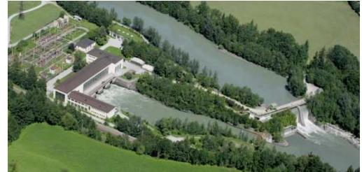
Wasserkraftwerk Schwarzach am Ufer des Flusses Salzach
