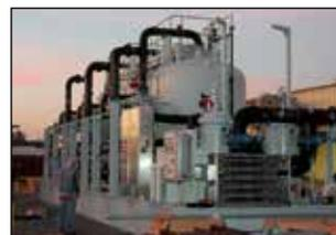
„Produced Water“ Anlage mit BOLLFILTER Automatik TYP 6.18, Filterfeinheit 50 Mikron
