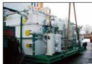
Schmierölversorgungsanlage für Kompressor Station mit BOLLFILTER Duplex TYP BFD-P
